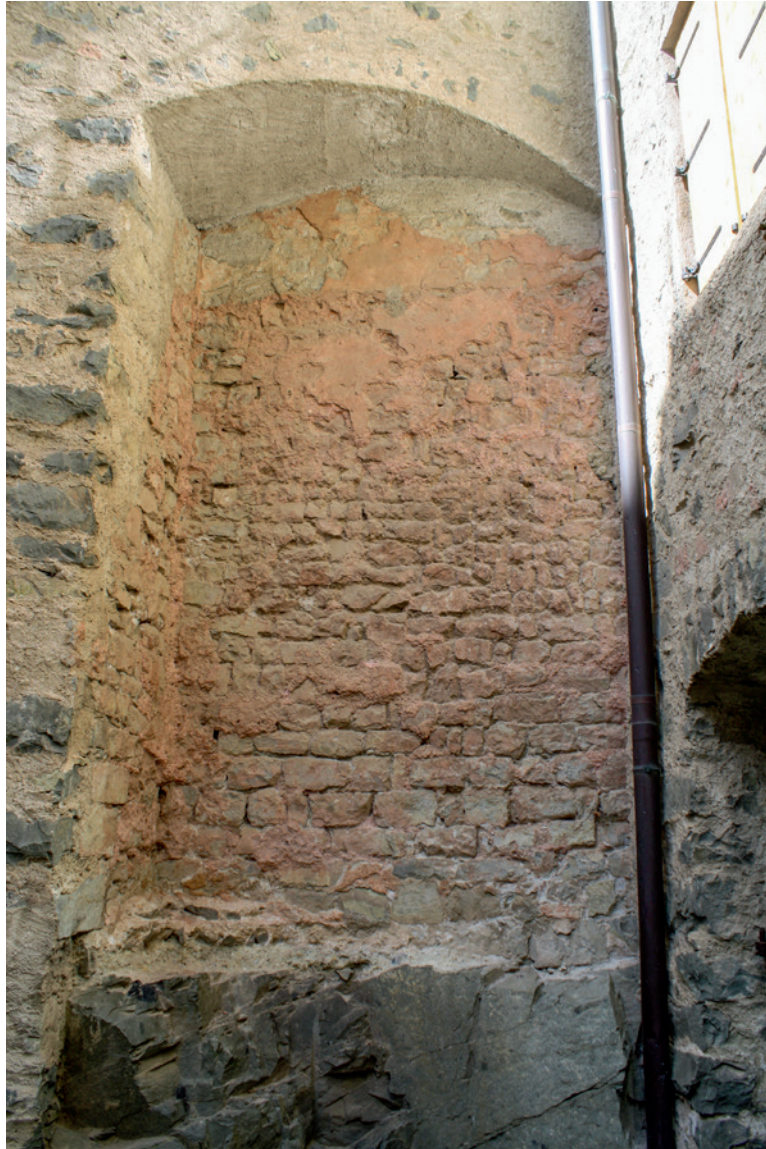
Abb. 9. Säben „Burgberg“. Die mit wasserdichtem opus signinum verputzte Wand einer vornezeitlichen Zisterne ist heute in der Außenmauer im Klosterhof zu sehen.
