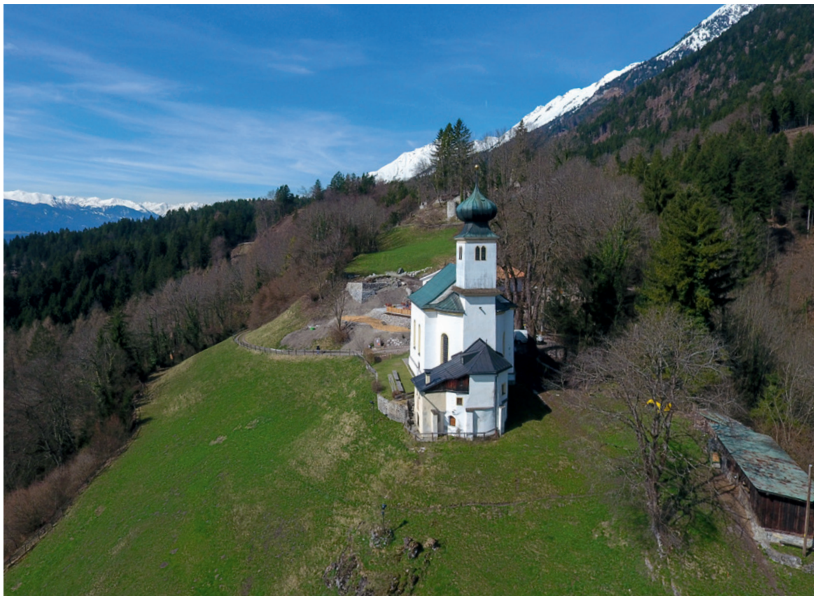
Abb. 4. Thaur, Burg und Romedibichl. Drohnfoto der Romedikirche von Osten. Links neben der Kirche ist die restaurierte Mauer der Vorburgumwehrung zu erkennen, oberhalb im Hintergrund die Ruinen der Burg Thaur.
