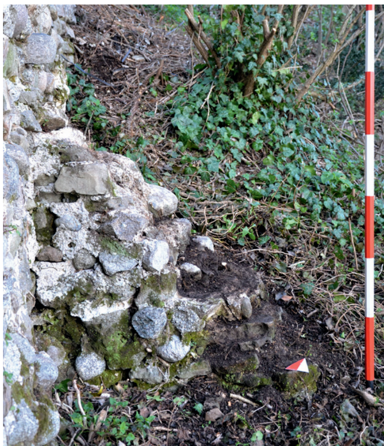
Fig. 7. Castello Baradello. Area 3: struttura USM 3009.
