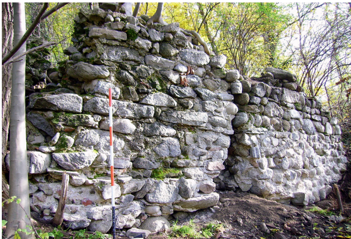
Fig. 13. Castello Baradello. Area 6: struttura USM 6002.
