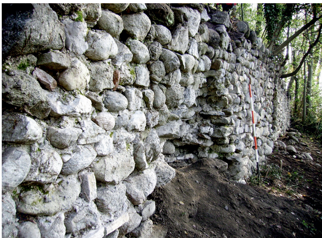
Fig. 3. Castello Baradello. Area 6: tratti di murature identificate (prima e dopo l'intervento di pulizia dei prospetti dalla vegetazione).
