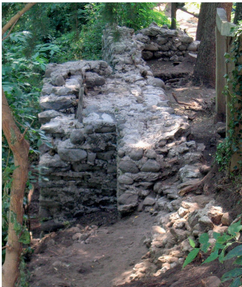
Fig. 15. Castello Baradello. Area 2: struttura USM 2001.
