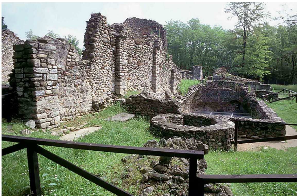
Fig. 12. Castelseprio. La cisterna addossata al perimetrale sud della basilica di San Giovanni Evangelista.
