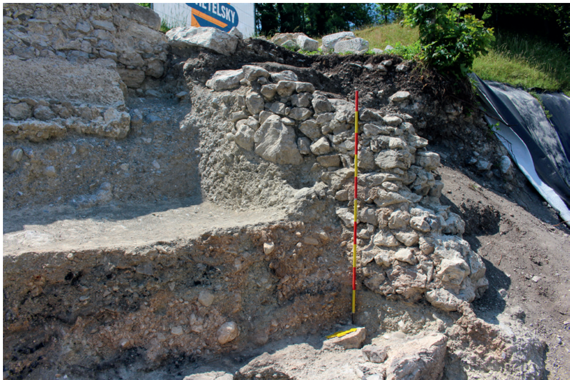
Abb. 7. Thaur, Burg und Romedibichl. Ansicht des zur spätantiken Bauphase 1 gehörigen Mauerrests SE 2, von Süden aus gesehen.
