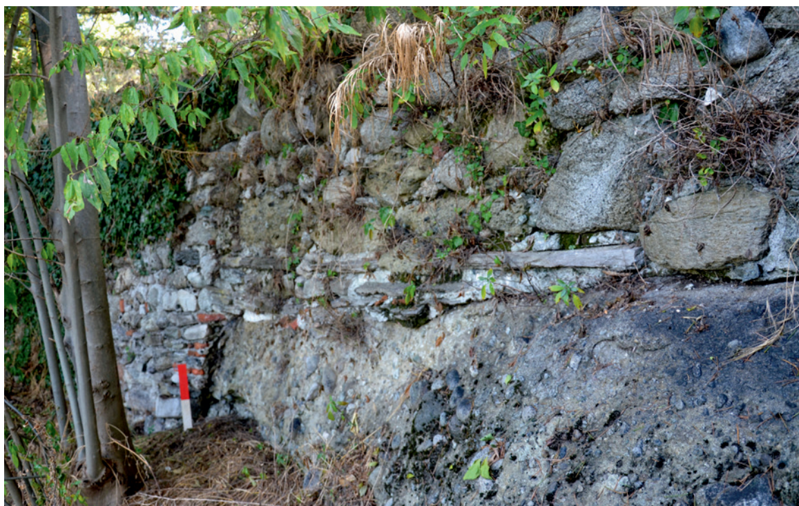
Fig. 14. Castello Baradello. Area 1: tratto di cortina impostato a contatto con il substrato roccioso.
