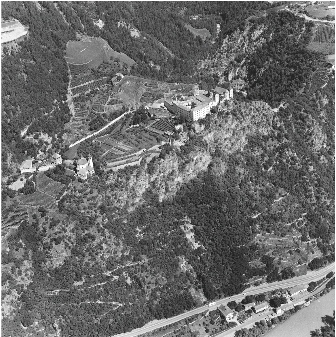
Abb. 4. Burgberg von Säben, oberer Teil: Bebauung wie Abb. 3, von Osten.
