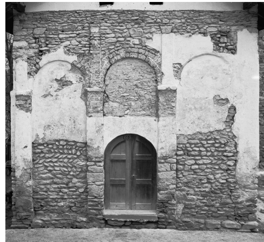
Abb. 2. Cazis St. Martin, Westfassade während der Bauuntersuchung 1968.
