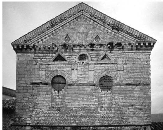
Abb. 16. Poitiers, Baptisterium Saint-Jean, Südfassade. Zwergpilaster setzen auf Kämpferhöhe der Fensterbogen an. Foto HR. Sennhauser.
