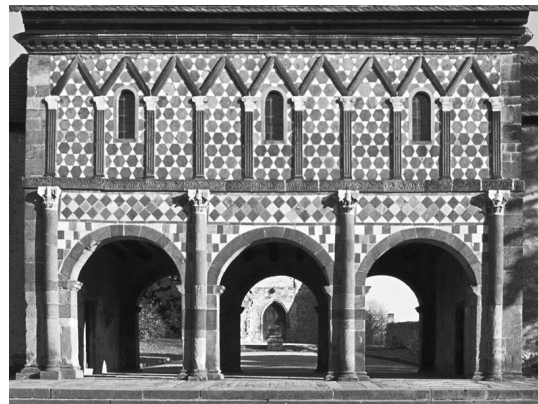
Abb. 20. Lorsch, Torhalle, 774 vollendet. Die vorgelegten Halbsäulen übergreifen die Arkaden (wie Abb. 19). Sie sind auf der Höhe der Arkadenkämpfer eingebunden, ohne dass hier ein Schafring vortritt. Die Zone über den Arkaden bereitet optisch das Gebälk vor (wie Abb. 17). Foto HR. Sennhauser.
