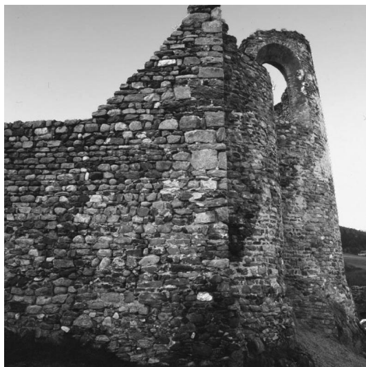
Abb. 3. Sonnenburg, Stiftskirche. Ansicht des Kirchenostabschlusses von Süden. Besonders gut sind die Orthostatenplatten und das lagige Bruchsteinmauerwerk zu erkennen. Im Bereich der Apsiden ist noch grossflächig der Fugenverputz mit Kellenstrich vorhanden.
