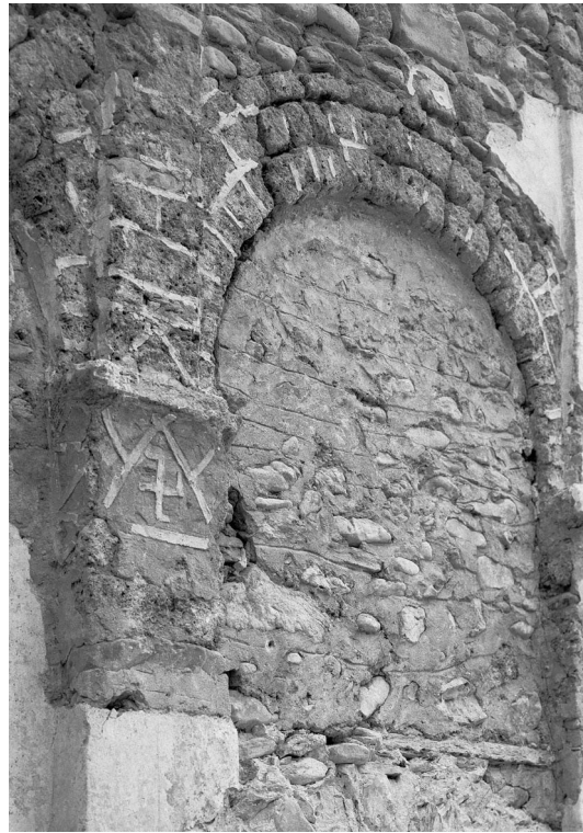
Abb. 4. Cazis, St. Martin, Westfassade, Ausschnitt. Der mittlere Bogen ist aus zwei Reihen von Tuff-Keilsteinen und einer dritten Lage tangential gelegter, länglicher Steine gefügt. Die Fugen an Pilaster und Bogen werden von weissen, 3–4 cm breiten, erhaben gearbeiteten, an den Seiten scharf beschnittenen Stegbändern überdeckt. Im «Tympanonfeld» horizontale Fugenstriche und sichtbare Steinköpfe.
