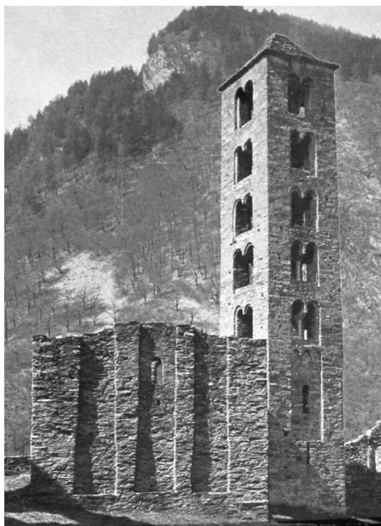
Abb. 18. Mesocco, S. Carpoforo (A61), Ostansicht mit Turm.
