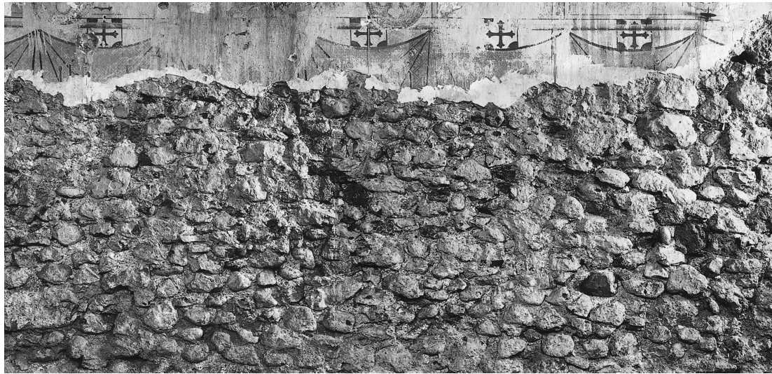
Abb. 3. Nordwand der Kirche, Innenseite mit dem Mauerwerk der Bauphase 1: Das Mauergefüge zeigt keine Regelmäßigkeit, die verwendeten Bach- und Bruchsteine sind nicht bearbeitet. (Foto: Bundesdenkmalamt Wien, 1993).
