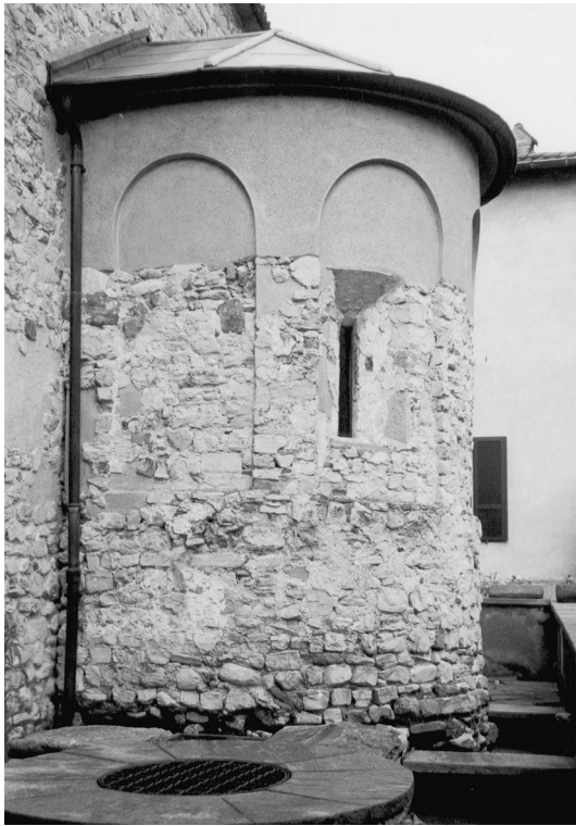
Abb. 6. Riva S. Vitale, Baptisterium, nachträglich an Bau II angebaute Apsis, von S.
