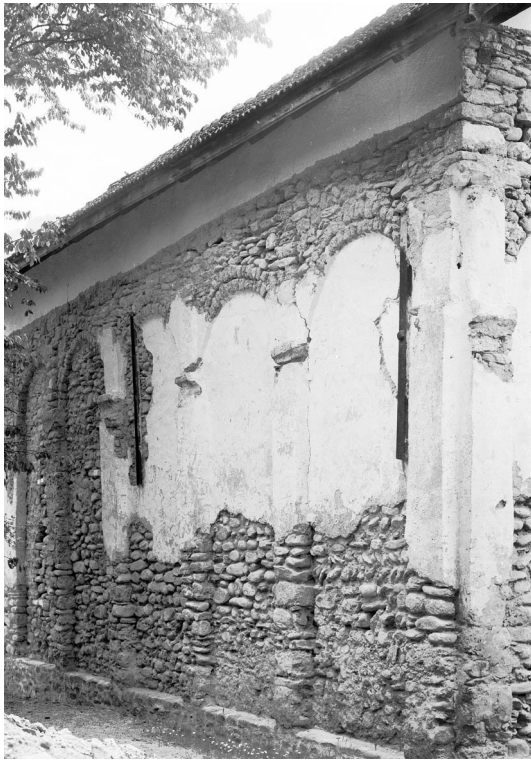
Abb. 3. Cazis, St. Martin, Nordfassade während der Bauuntersuchung 1968.
