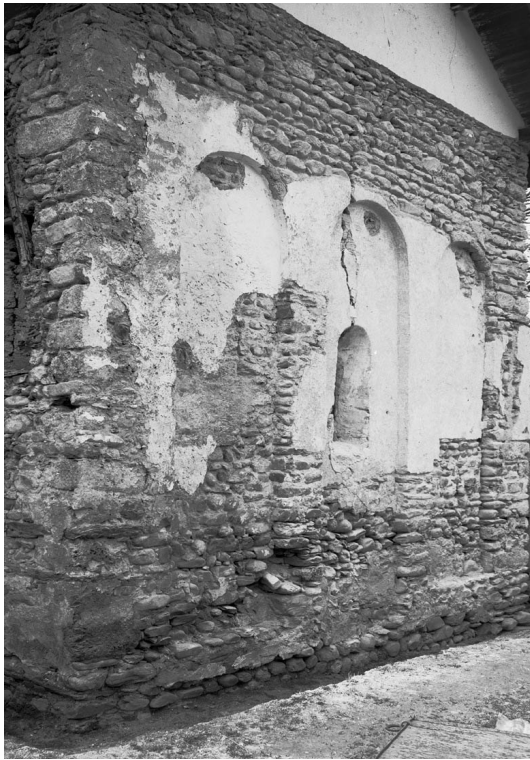
Abb. 8. Cazis, St. Martin, Ostfassade während der Bauuntersuchung 1968.
