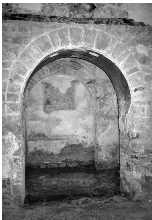
Abb. 21. Müstair, Ulrichskapelle, Triumphbogen. Fugen zwischen den Keilsteinen geglättet und gekalkt. Die Begrenzungslinie der Keilsteine beschreibt einen gestelzten Bogen.
