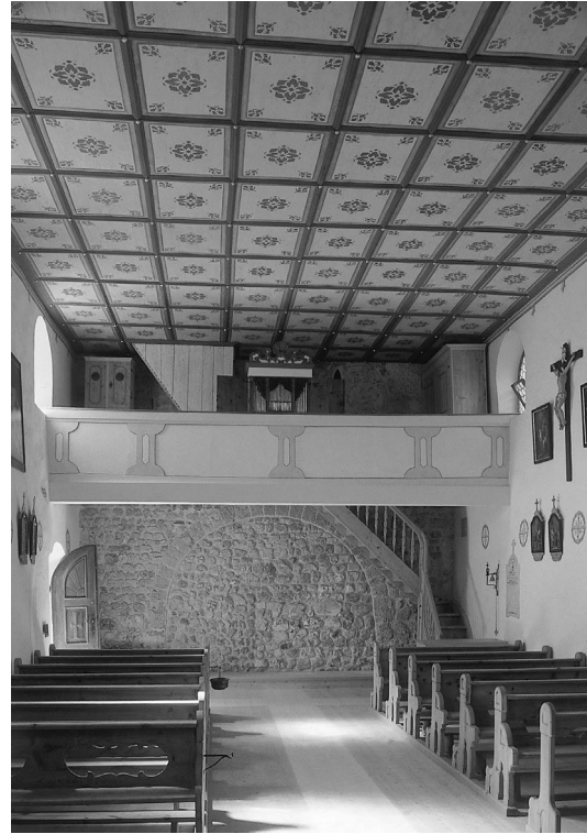
Abb. 6. Westansicht des Kirchenraumes mit der Umgestaltung der Kirche um die Mitte des 16. Jahrhunderts. Zu erkennen sind: Die Renaissancedecke, die im Barock neuerlich veränderte Empore und im Bildhintergrund die nach der Restaurierung sichtbar belassene Wand des romanischen Westbaues. (Foto: Bundesdenkmalamt Wien, Zustand 1999).
