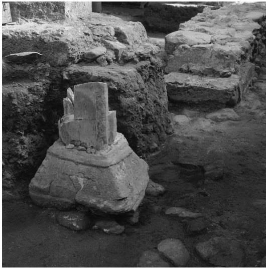
Abb. 20. Bischofshofen, Pfarrkirche, Bau 2. Basis eines Pfeilers in der Trennmauer zwischen Mittelschiff und südlichem Seitenschiff.
