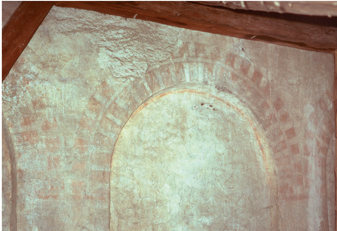
Abb. 11. Münstair, Klosterkirche, Nordfassade. Aufgemalter Backsteinbogen im Farbwechsel.
