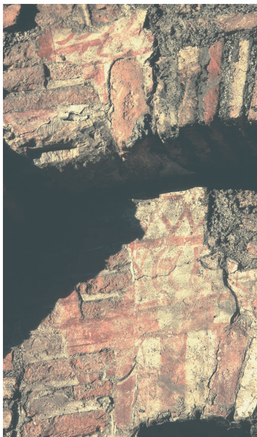
Abb. 23. Brescia, S. Salvatore, Südfassade. Verputzreste mit Ornamentbemalung.
