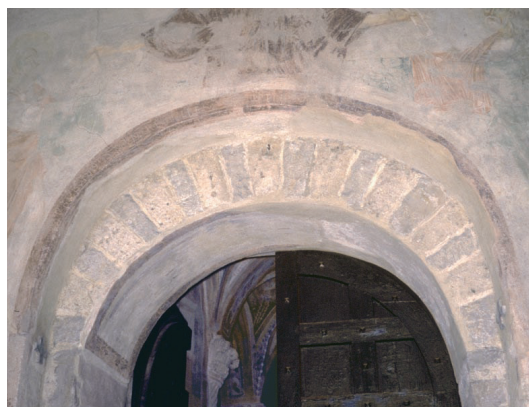
Abb. 20. Civate (Como), S. Pietro, Portal. Keilsteine des Bogens sorgfältig ausgefugt und geweisst.
