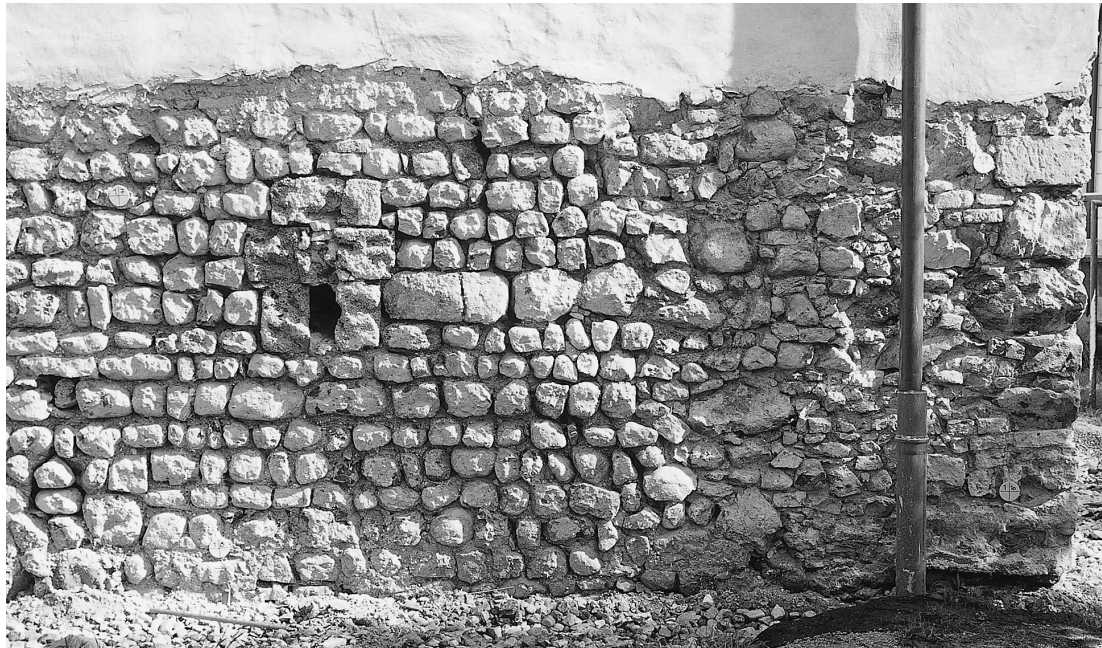
Abb. 5. Ulrichhof, Nordseite, Mauerwerk der Bauphase 2 im Bereich der Westecke: Das kleinteilige Mauergefüge zeigt eine strenge Lagigkeit mit zonalem Lagenversatz. Das Gesteinsmaterial ist ansichtsflächig zu Kleinquadern behauen. Der Lichtschlitz besteht aus Kalktuffquadern. Rechts im Bild sichtbar die Erneuerung der Ecke im 16. Jahrhundert unter Wiederverwendung von Abbruchmaterial und Ziegeln. (Foto: P. Knapp, Innsbruck, 1999).
