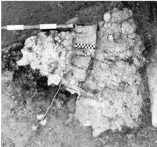
Abb. 8. Domat/Ems, St. Peter. Verstürzte Fassadenverkleidung, Detail.
