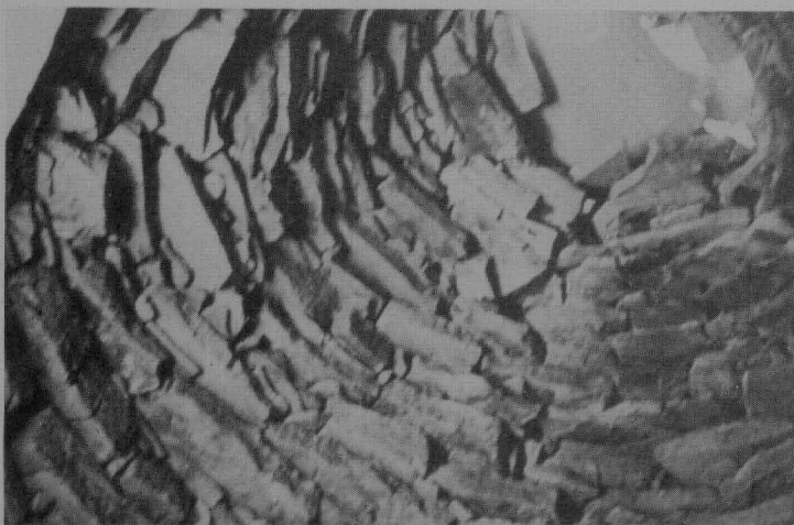
4. Teil des Deckengewölbes einer casèla im westlichen Ligurien, s. Anm. 14
