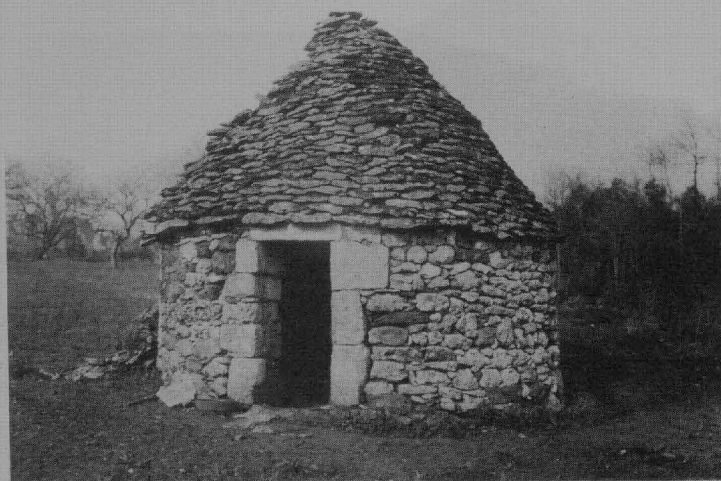
2. Eine casita bei Dignano (Istrien) mit Rauchabzug, s. Anm. 29
