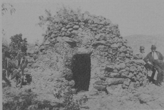
3. Hütte aus Lavablöcken im Gebiet von Bronte an den Hängen des Ätna, phot. Rohlf's
