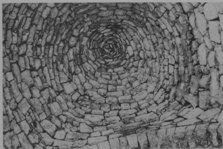
3. Deckengewölbe einer Seitenkapelle von S. Pietro in Balsignano bei Modugno (Prov. Bari), phot. Rohlfs
