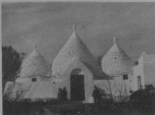
1. Bauernhaus bei Ceglie (Prov. Brindisi), phot. Rohlf's
