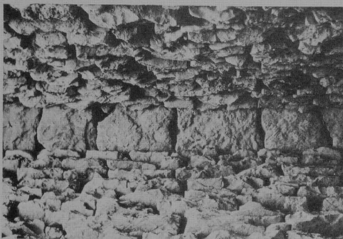
2. Abschluß des Gewölbes in der Firstlinie einer Steinhütte bei La Roque-sur-Perthes (Vaucluse), phot. Rohlf
