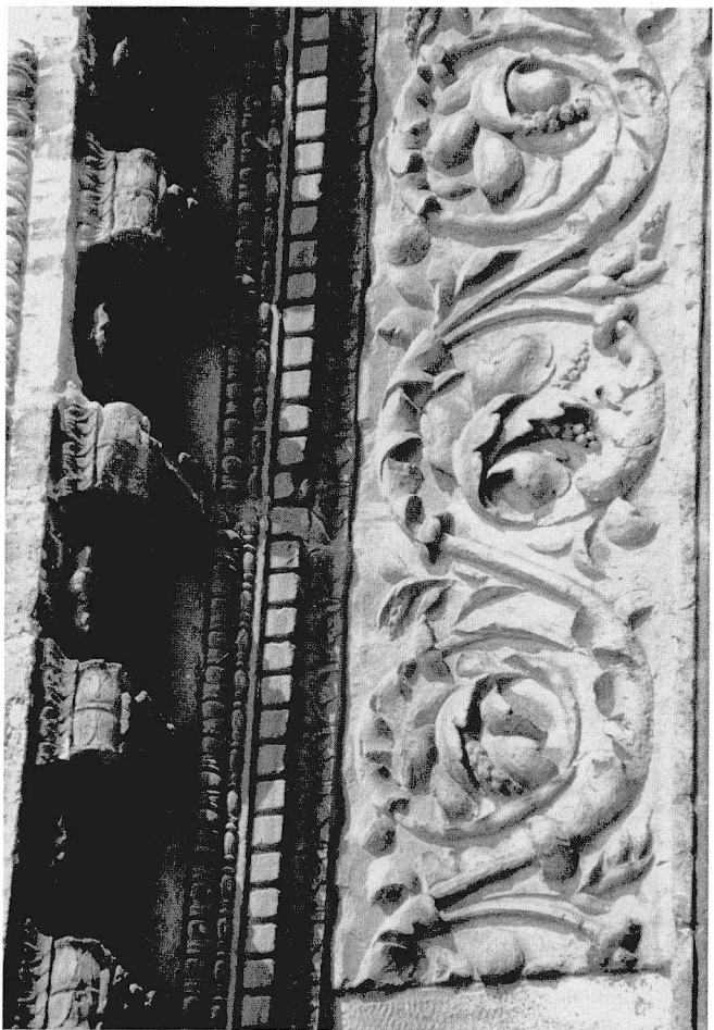
FOR 7, Ostempel, Fries der Rückseite: a. – d. Ansicht von Ost nach West
