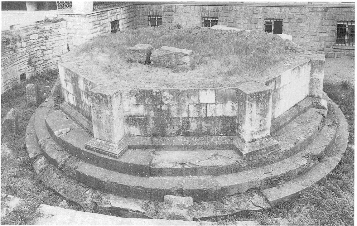
SUB 13, Oktogon: a. Gesamtansicht des Sockels
