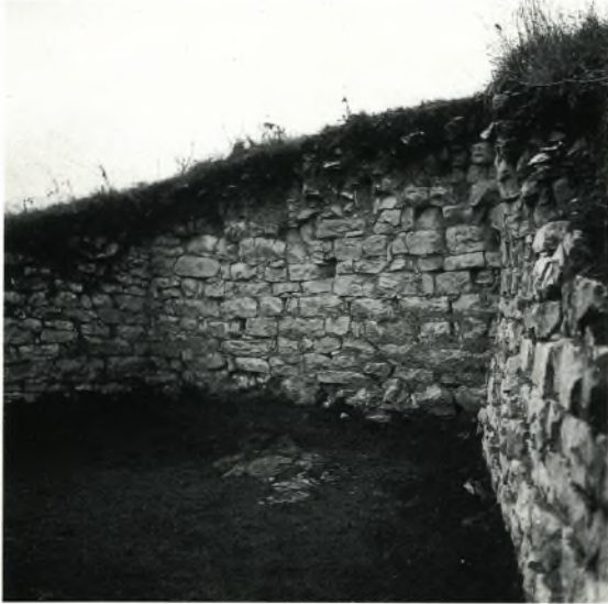
1 Turm F an der Ostmauer: Innenansicht.
