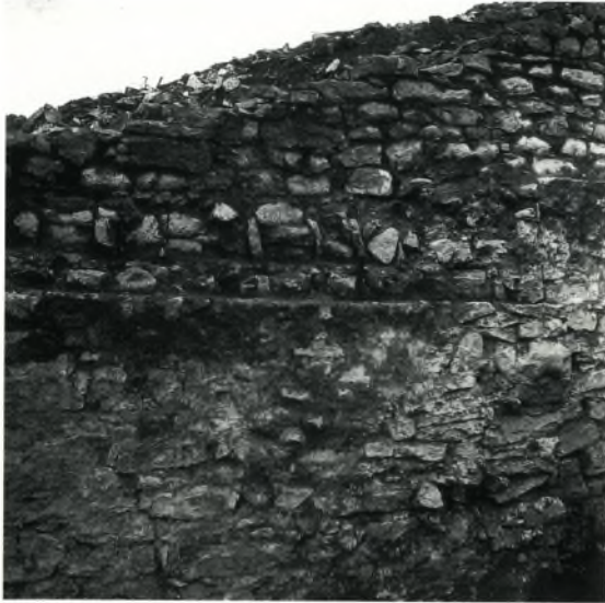
1 Südwand mit Auflager für Holz.
