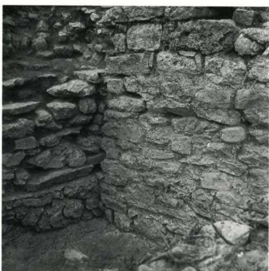
4 Blick von O auf die Baufuge zwischen der Süd- ostecke von Turm E und Festungsmauer 3.
