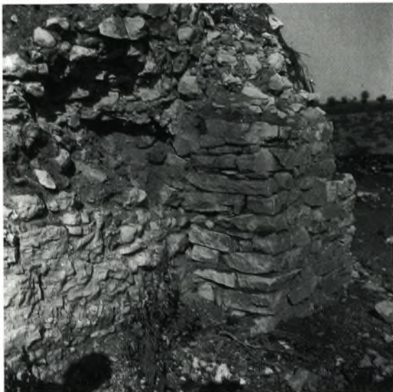
1 Turm A: außen angesetzter Pfeiler an der Südostecke.
