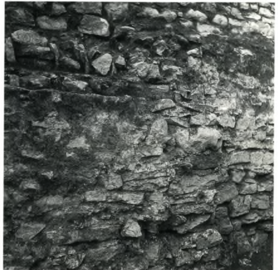
2 Südwand mit Auflager für Holz.
