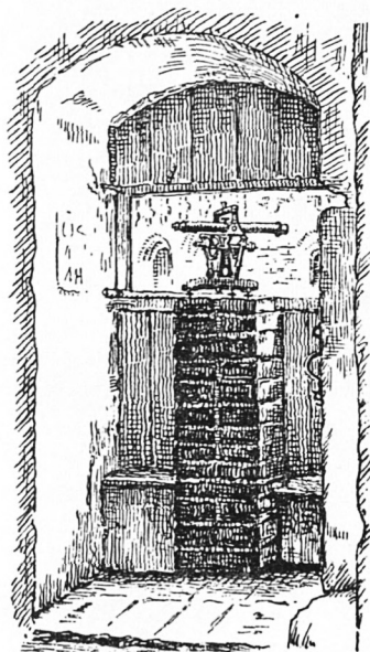
Ansicht vom Pfeilereinbau im nördl. Turm
