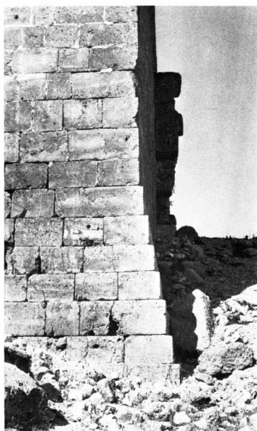
Taf. 5,1. Kale'i Zerzevan. Turm 1: Stufenaufbau der Basis (Peschlow).
