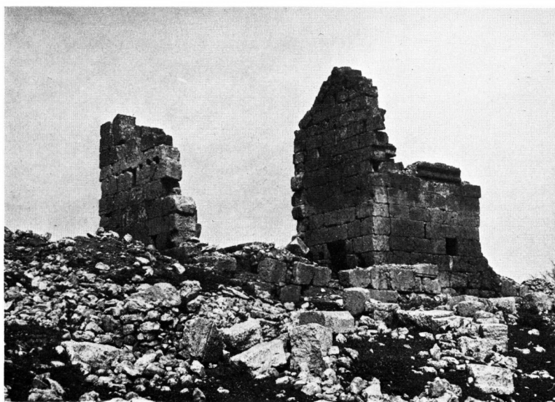
Taf. 9,2. Kale'i Zerzevan. Kirche: Südraum und Apsisnebenraum von Osten (Deichmann).
