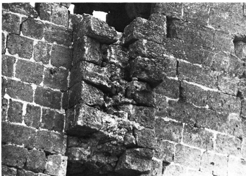
Taf. 2,1. Kale'i Zerzevan. Turm 1: Ansatz des Schalenmauerwerks (Deichmann).
