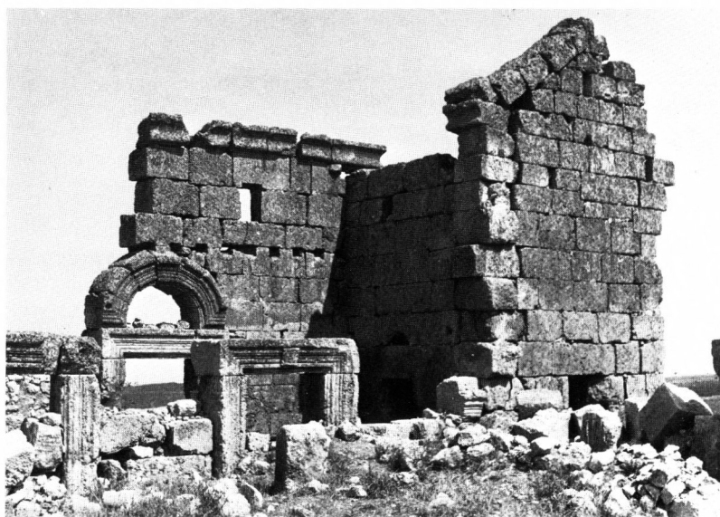
Taf. 8,2. Kale'i Zerzevan. Kirche nach Einsturz der Westmauer des Südraumes. 1973 (Peschow).
