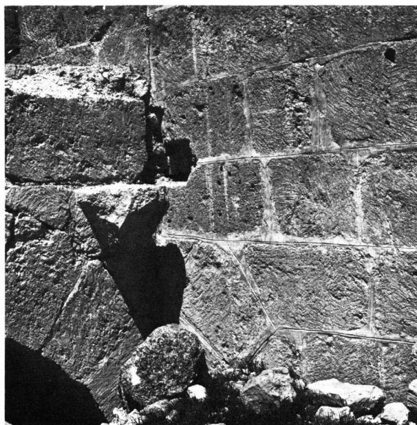
Taf. 4,2. Kale'i Zerzevan. Turm 1: Streichbalken-Konsole (Peschlow).
