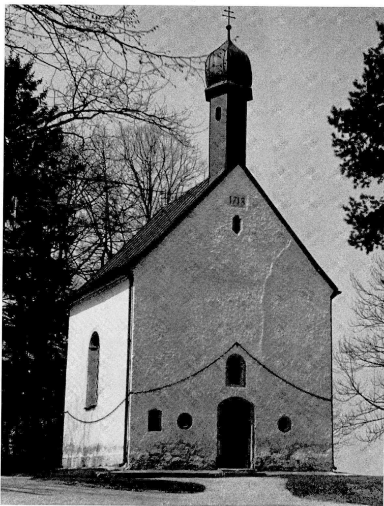
Abb. 1: Kettengürtel (1743) am St. Leonhardskirchlein zu Bad Tölz.
