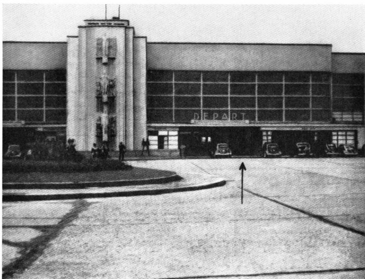
Fig. 12. Paris le Bourget, Aéródrome, hall central, porte d'accès
