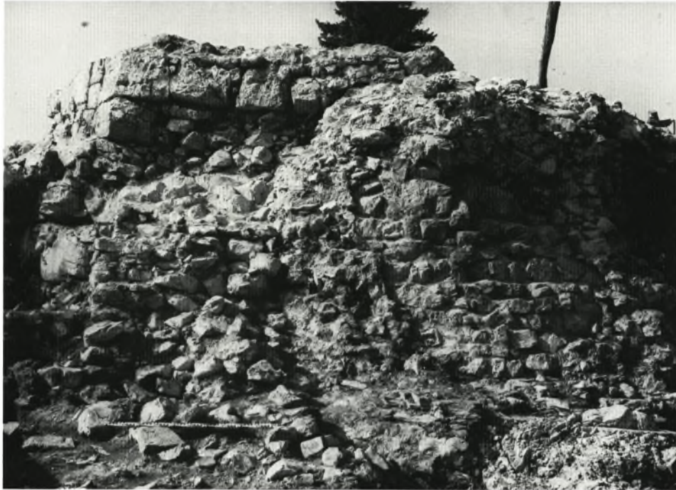
a Ad pirum -Hrušica, Kastell-Osttor, Südseite. Spätantiker Mauerbestand der Kastellmauer und des Torturmes, darauf gotischer Ostchor der Gertrudiskapelle.
