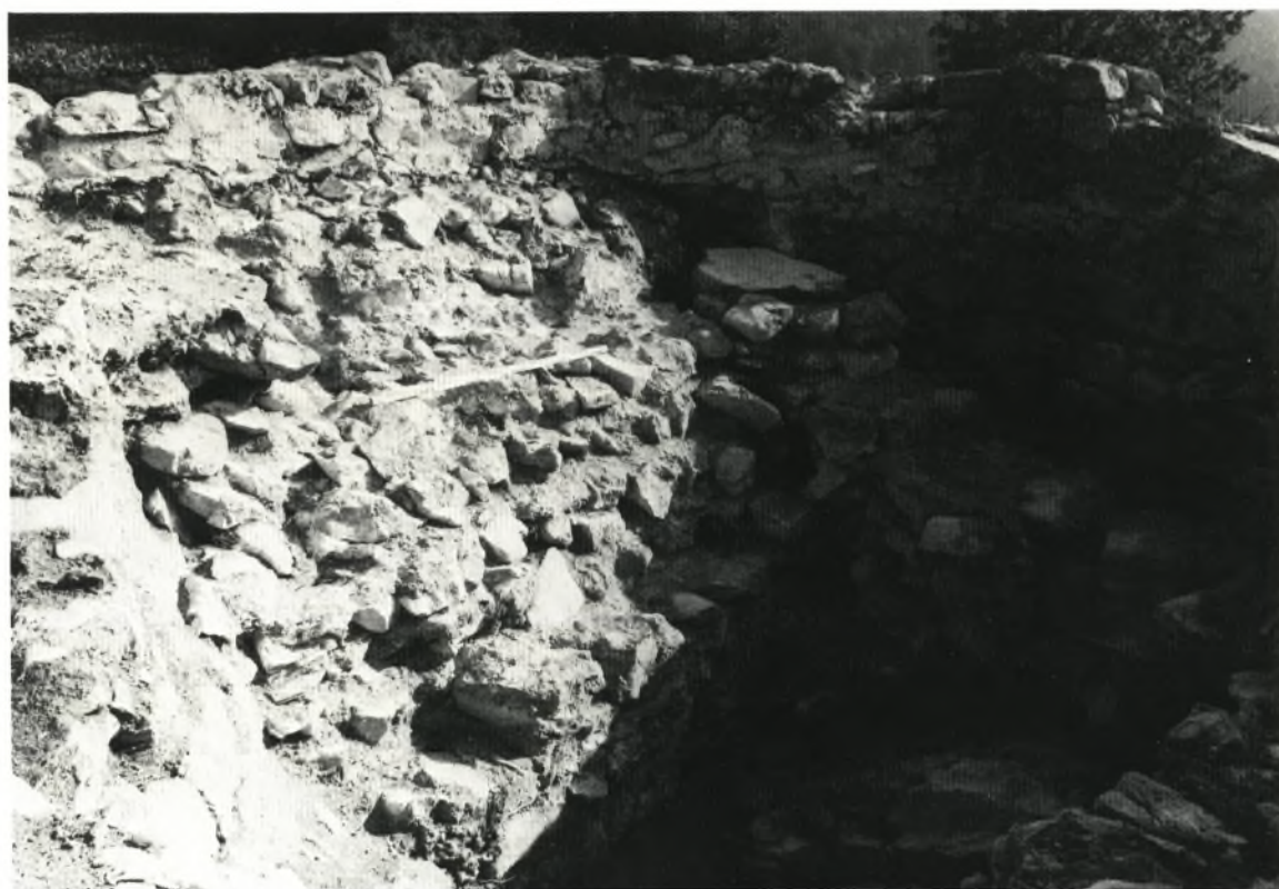
b Ad pirum -Hrušica, Kastell-Osttor, Südseite. Spätantikes Turmmauerwerk innerhalb des gotischen Ostchores der Gertrudiskapelle.
