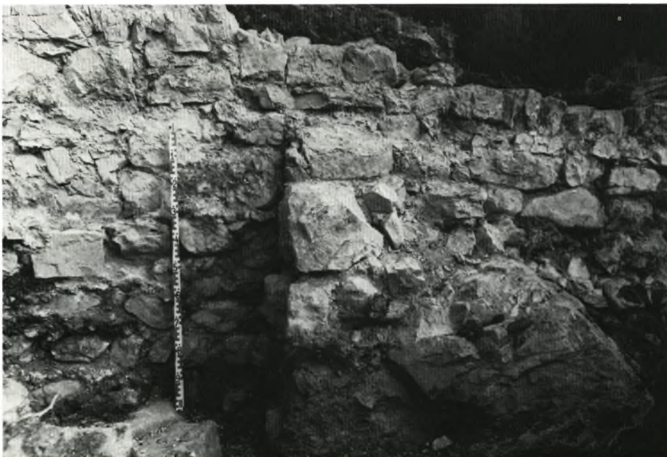
b Ad pirum -Hrušica, Schnitt X. Baufuge zwischen Rechteckbau und westlicher Erweiterung der Gertrudiskapelle.
