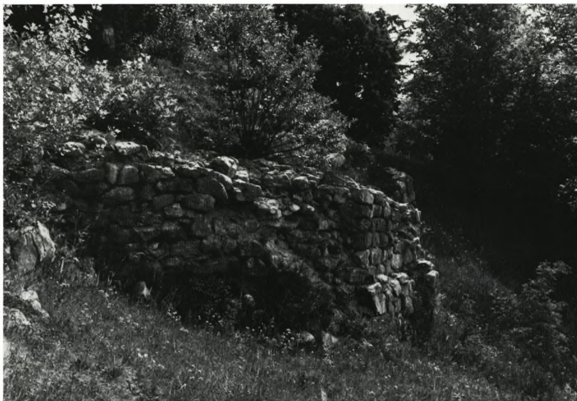
a Ad pirum -Hrušica, Turm in Zwischenmauer zwischen Ober- und Unterburg.
