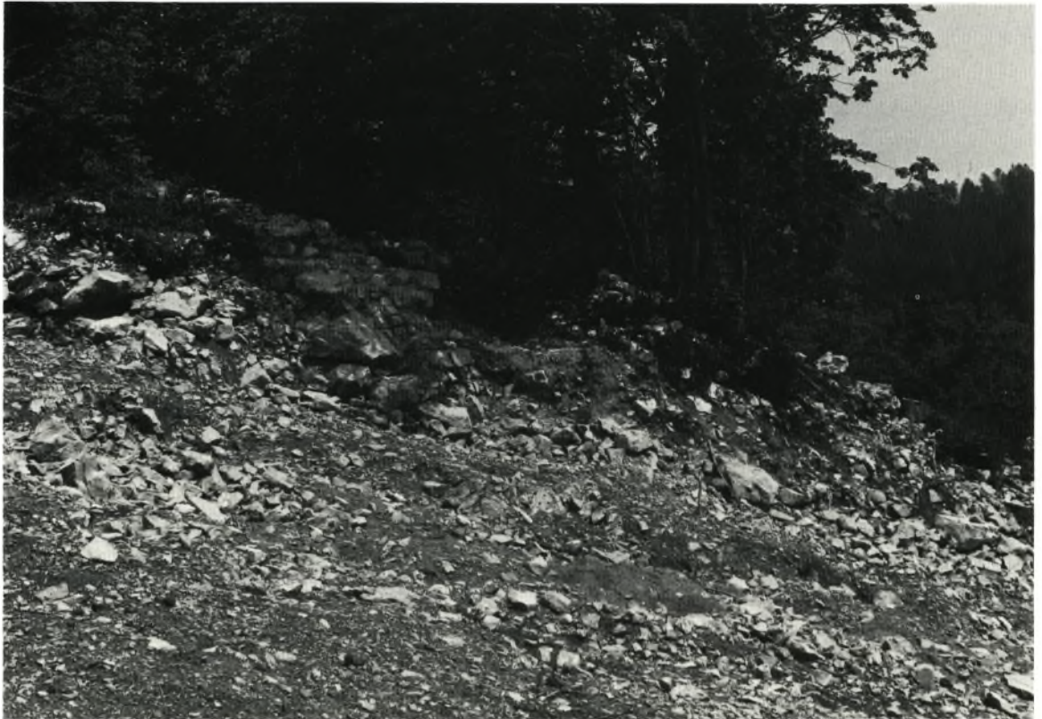
a Ad pirum -Hrušica, südöstliche Sperrmauer. Sie ist im Wald noch zu sehen. Im Vordergrund ist sie durch die moderne Erdgasleitung zerstört.
