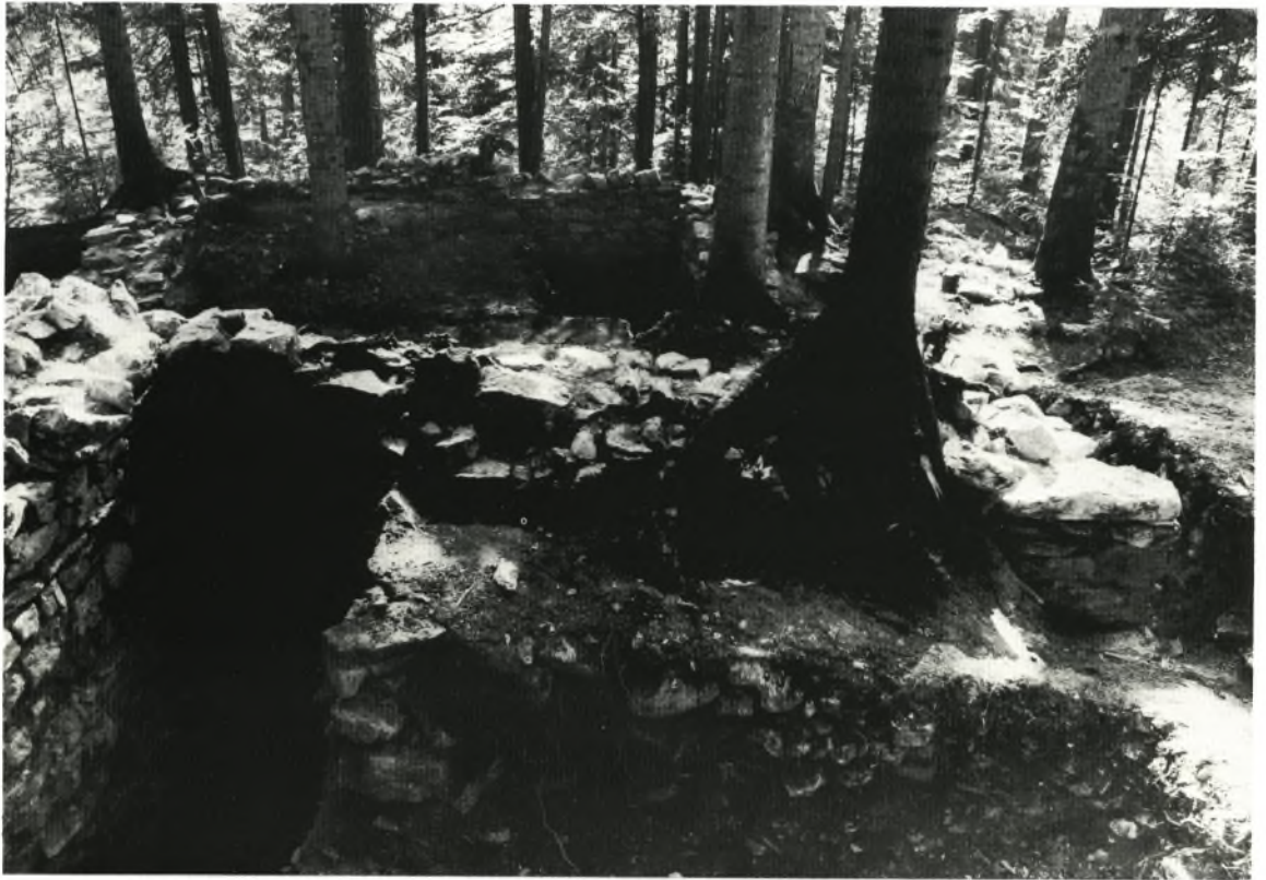
a Ad pirum -Hrušica, Walltor. Anschluß der Sperrmauer im Nordwesten.
