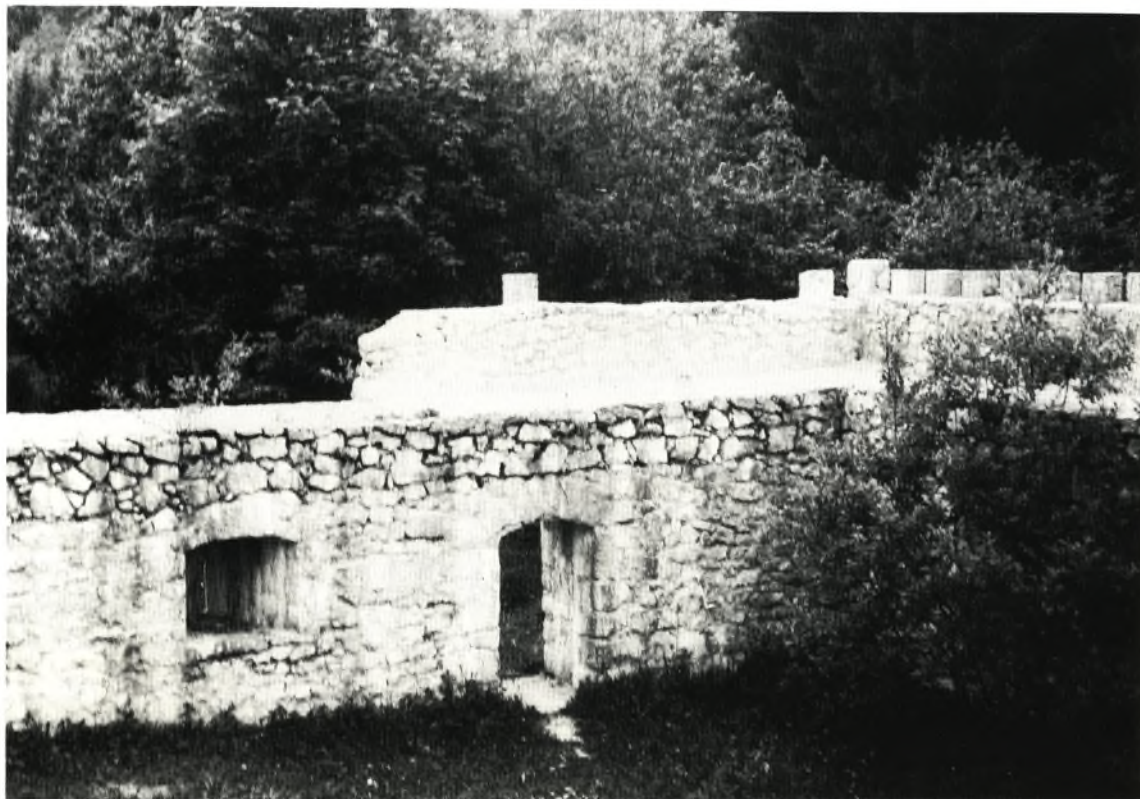
a Lanišče. Spätantike befestigte Station, teilweise restauriert.
