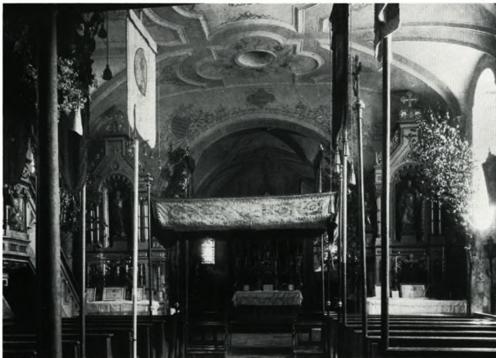
Kirche St. Peter u. Paul im Jahre 1898. 1 Ansicht von Süden; 2 Innenansicht.
