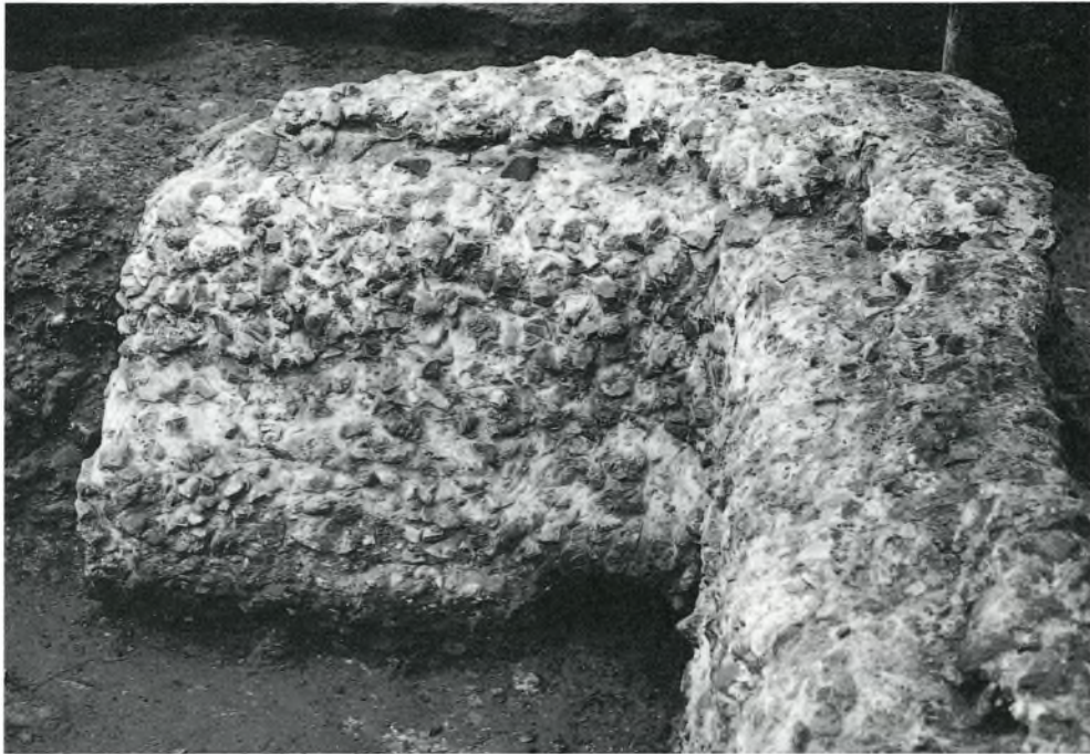
Abb. 46. Ostplateau, Wasserbecken. Nordostecke der Mörtelmauer. Blick von Süden.
