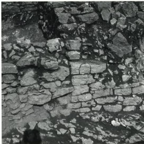
3 Außenseite der Südwand mit der Fuge zwischen Schiff (rechts) und Vorhalle (links).
