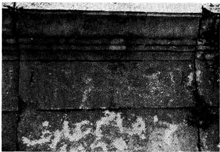
Abb. 16. Me'ez, Ostkirche. Profilquader mit Positionsmarken.
