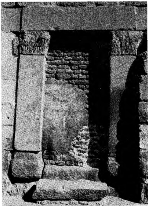
Abb. 23. Der el Abyad. Südportal der Westseite.
