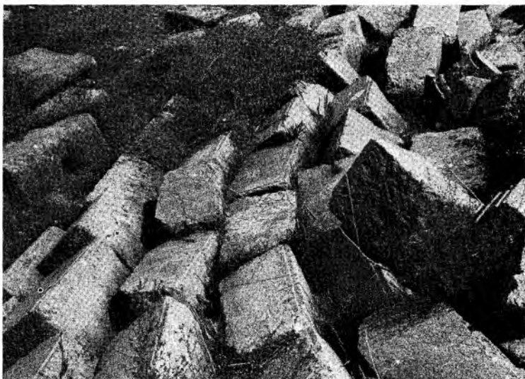
Abb. 11. Anazarbos, Apostelkirche. Südwand in Sturzlage.
