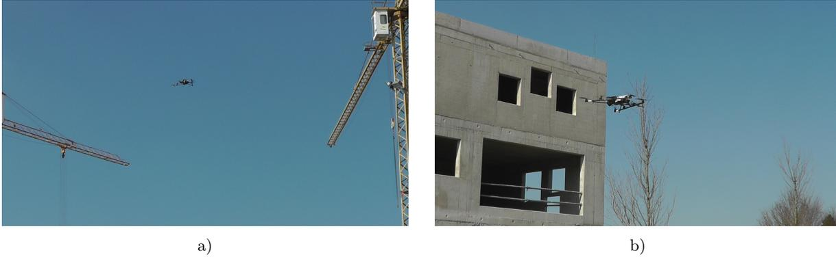
Abbildung 5.7: UAV-Erfassung, a) Kranstellung, b) UAV vor Gebäude bei Schrägsichtaufnahme
